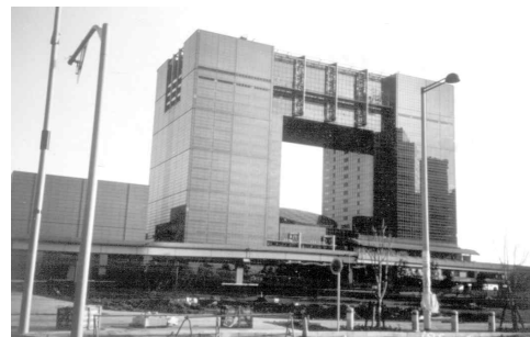
그림9 일본 동경의 해안부근에 세워진 오피스 빌딩. 바람을 가장 강하게 받는 중앙부분이 뚫려있다.
