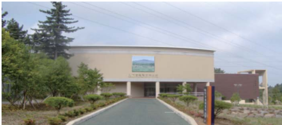
자연생태체험학습관 전체 외부 전경
