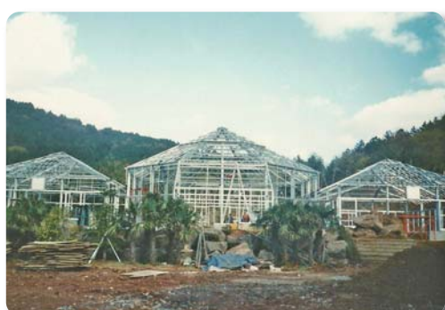
온실트러스 공사 중
