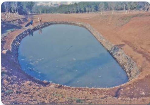
수생식물원 완료 후 물 채움
