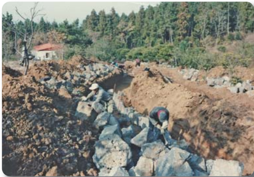
지금의 난전시설 앞 배수로 공사(1987년)
