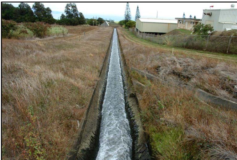
<사진 4-8> 마우이섬 East Maui Irrigation System의 수로 모습
