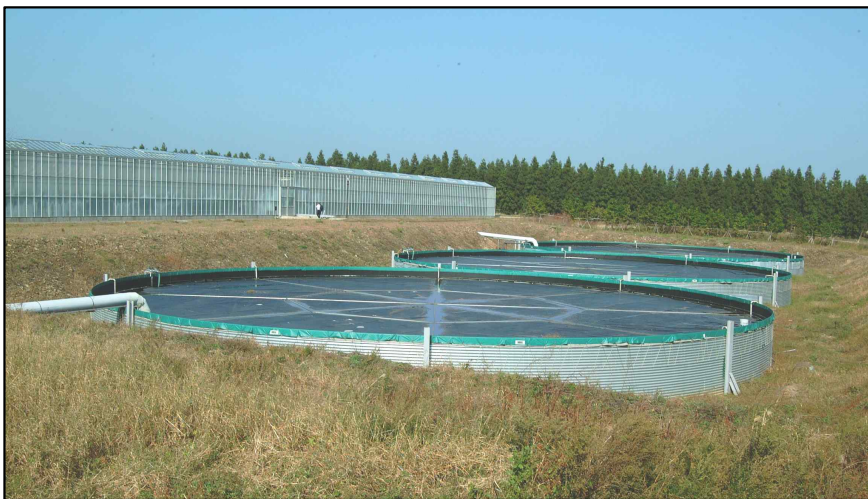
<사진 2-1> 한국항공(주) 유리온실 빗물저장시설 설치 모습
