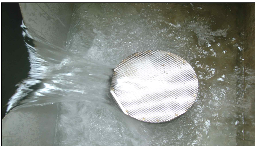
<사진 2-5> 지하수 인공함양정으로 빗물이 함양되고 있는 모습
