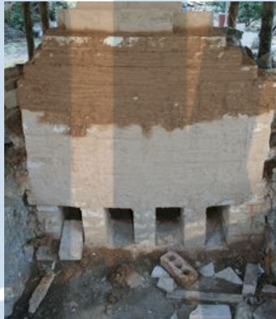
그림 100 뒷구멍(굴뚝) 만들기 과거에는 돌(현무암)으 로 제작했으나 본 연구 에서는 벽돌을 이용했다.
