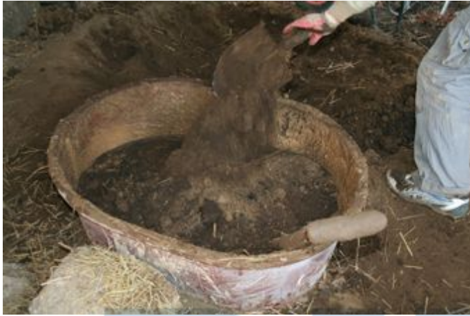
그림 102 외벽바르기 재료 작업 그림101에서 작업한 질과 흙을 그림과 같이 섞는다.
