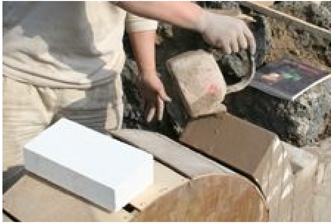
그림 96 가마문 만들기 가마문에 맞는 홍여를 받치고 아취 벽돌을 이용하여 양쪽에서 그 림과 같이 쌓아 올린다.
