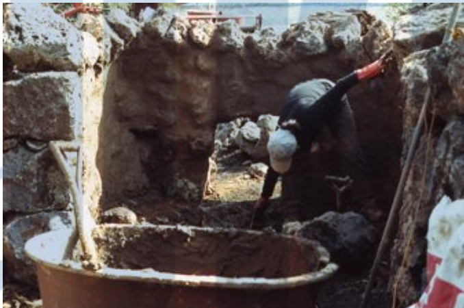
그림 88 내벽바르기 내벽바르기는 가마 제작이 끝난 시점에 하나 돌틈사이를 어느 정도 막는 내벽바르 기를 진행하였다.
