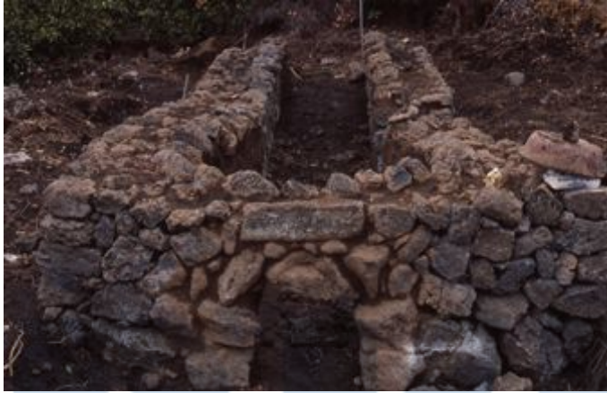
그림 87 가마벽쌓기 완성 가마벽 쌓기가 완성 되면 돌을 다지는 시간 을 가져야하는데 본 가마제작에서는 3개 월의 시간을 두고 진행 하였다.
