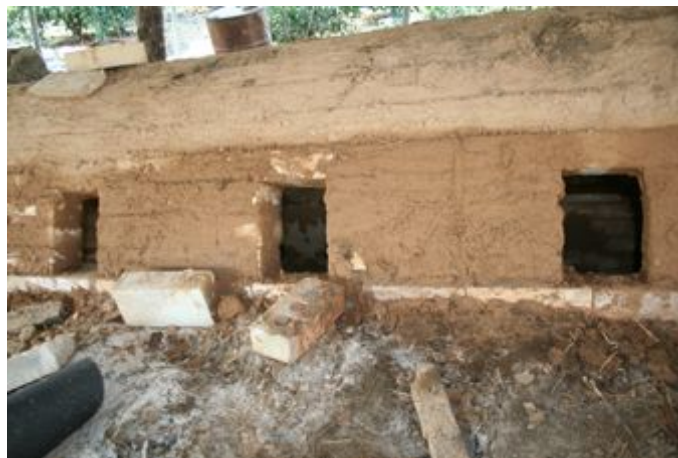
그림 98 창불구멍 천정작업과정에서 독새기구멍(창불구 멍)의 위치를 잡고 같이 진행시킨다.
