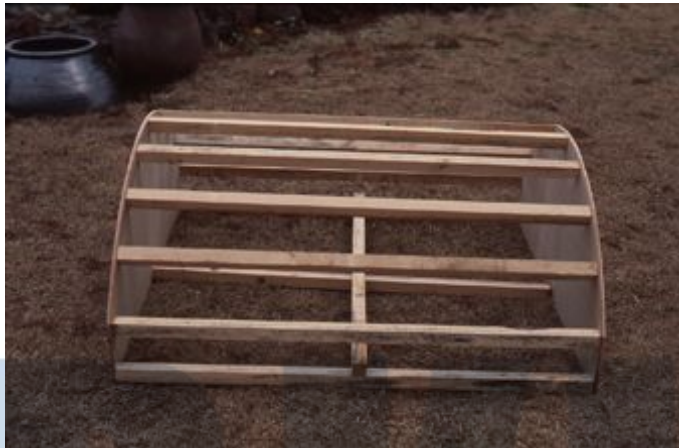
그림 90 홍여만들기2 나무를 이용하여 그 림과 같이 단단하게 만든다.
