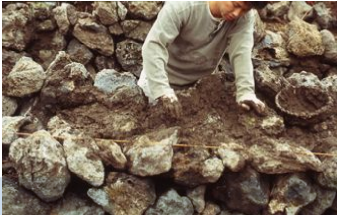
그림 83 가마벽 쌓기 현무암을 겹담으로 쌓아 그 사이를 흙과 잔 자 갈로 채워넣는 방식 으로 제작한다.
