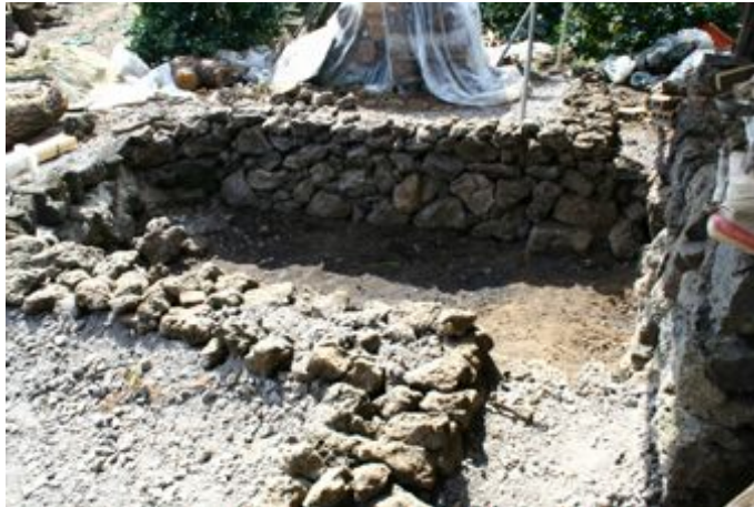
그림 80 부장쟁이 그림과 같이 본 연구의 돌가마 부장쟁이를 지면에서 1.5m 파고 돌을 쌓아 제작하였다.
