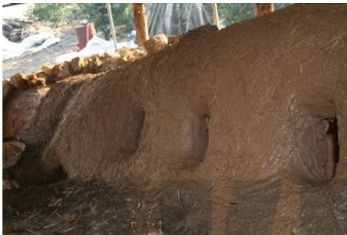
그림 105 외벽바르기 몇 차례에 걸쳐 외벽바 르기를 하며 건조상태를 보면서 두들겨 주면서 작 업 한다.
