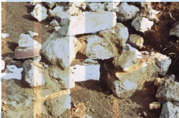
그림 81 아궁이 쌓기 돌가마쌓기 작업에 있어 처음하는 작업으로 두 개의 현무암을 땅속에 파 넣고 그 위에 넓은 현무암을 올려서 제작한다.
