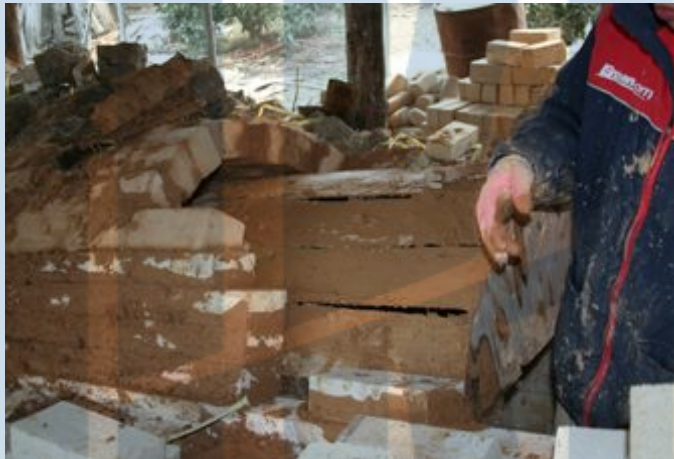
그림 97 천정쌓기 천정쌓기도 가마문제작 처럼 홍여를 받치고 양쪽에서 쌓는다. 이과정에서 유의할 점 은 벽돌과 벽돌을 겹 치지 않게 쌓는 것이다.
