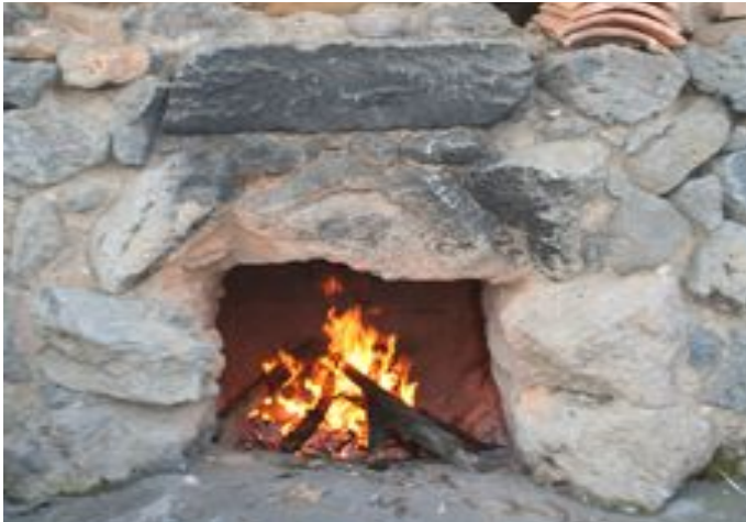
그림 115 피움불 가는 소나무를 이용하여 아궁이 입구에서 조금씩 천천히 진행시킨다.
