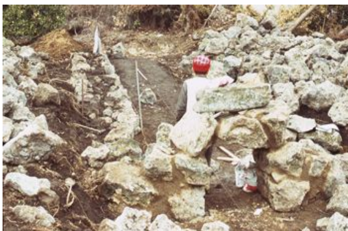
그림 82 기초돌 놓기 아궁이 쌓기가 끝나면 아궁이를 기준으로 구획하고 기초돌을 놓는다 이 작업도 돌을 땅속으로 파 넣는 방식으로 진행한다.
