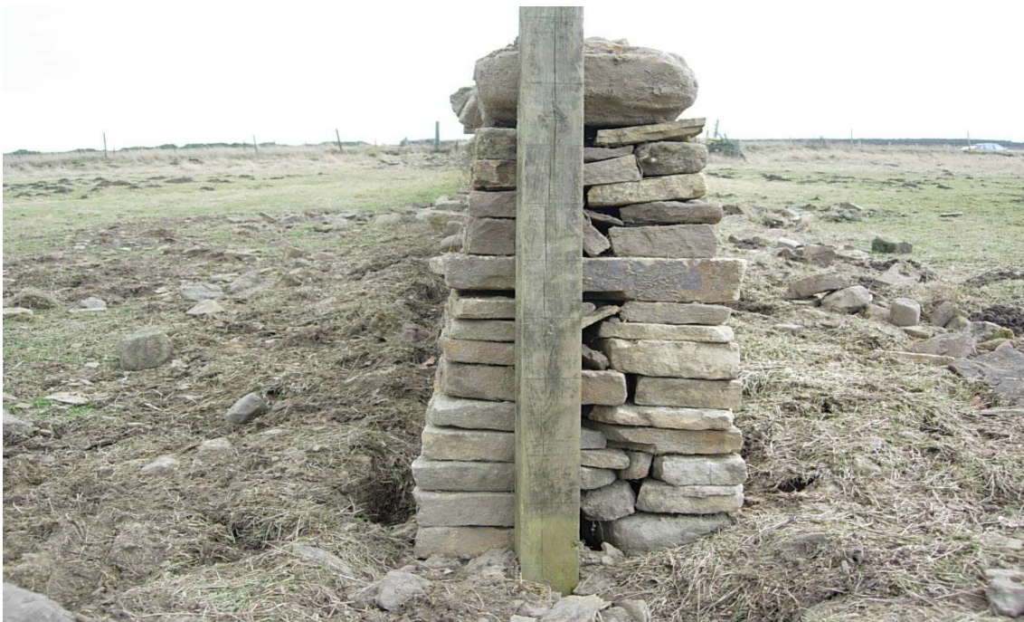
<그림 2-7> 영국의 목장 간의 경계물로서의 돌담을 신규 축조한 경우
