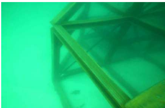
그림 2-6. 강정 연안바다목장 석재조합식어초(강제) 제작 및 설치.
