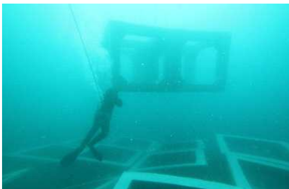
그림 2-7. 강정 연안바다목장 사각어초(콘크리트) 제작 및 설치.
