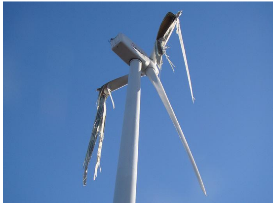
〈그림 3.10〉 강풍에 휘어버린 날개 (영양군 석보면 풍력발전단지)
