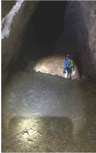
<셋알오름 동굴진지 내부 붕락 현황(사진, 3D스캔 이미지와 도면)>
