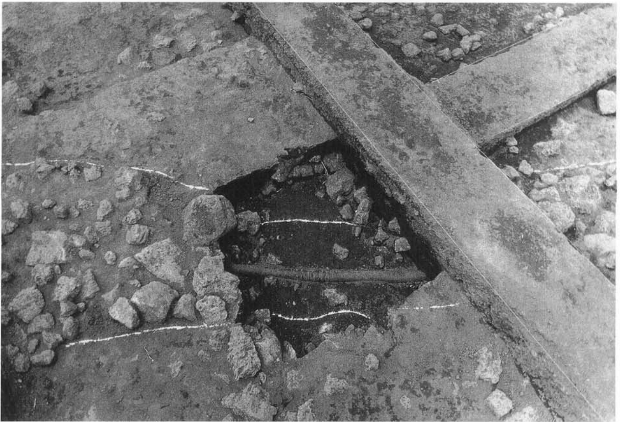
① 최근 학교건물 배수로내 테스트 피드 노출상태
