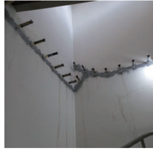
콘크리트 균열 보수
