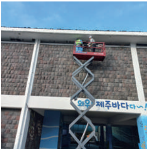
콘크리트 균열 보수
